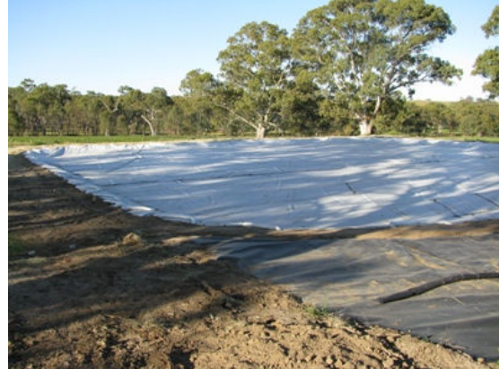
Couverture VapourGuard installée par FABTECH
