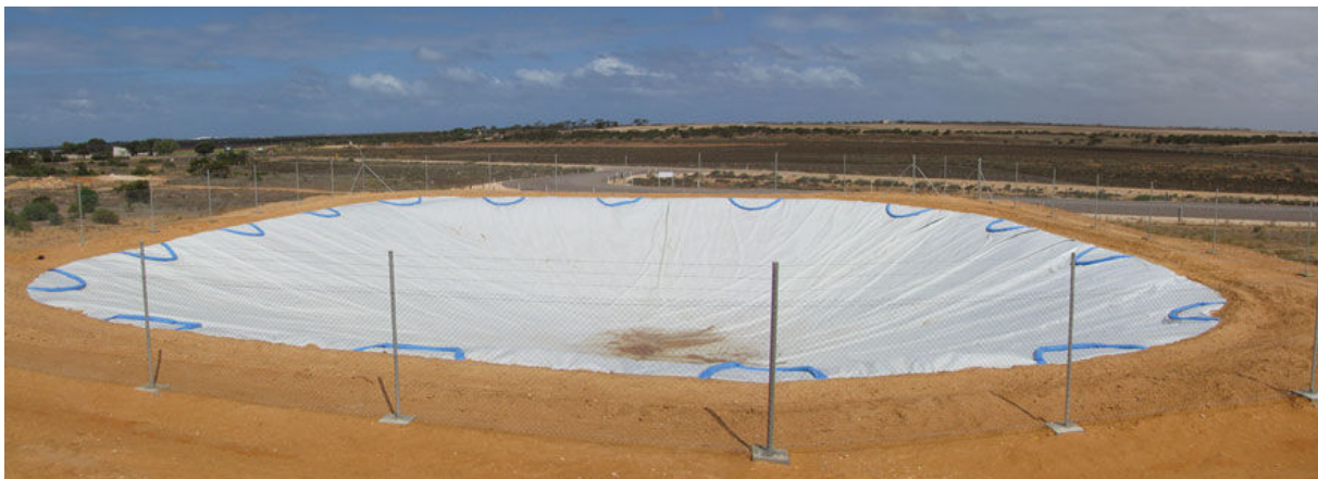
VapourGuard-Installation von FABTECH SA PTY LTD in Arno Bay, Südaustralien (1.800m 2 )
