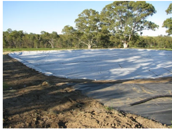
VapourGuard-Abdeckung von FABTECH installiert
