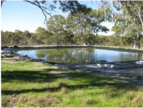
Staubecken vor Installation der Abdeckung
