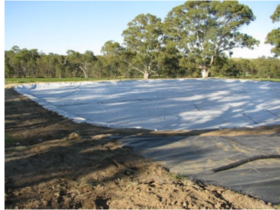
La copertura VapourGuard installata da FABTECH
